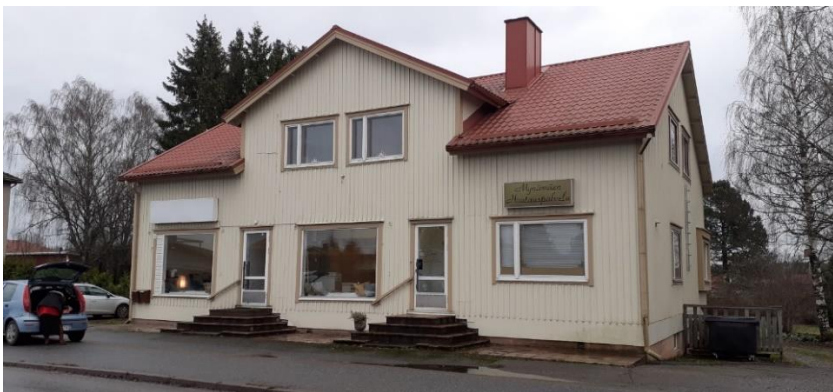
Kuvat 35 ja 36 Yläkuvassa liike- ja asuinrakennukset Joutsen ja Yrjölä. Alhaalla Joutsenen julkisivu Keskuskadulle (AJ)
